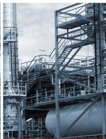
СТРОИТЕЛЬСТВО И МОНТАЖ
